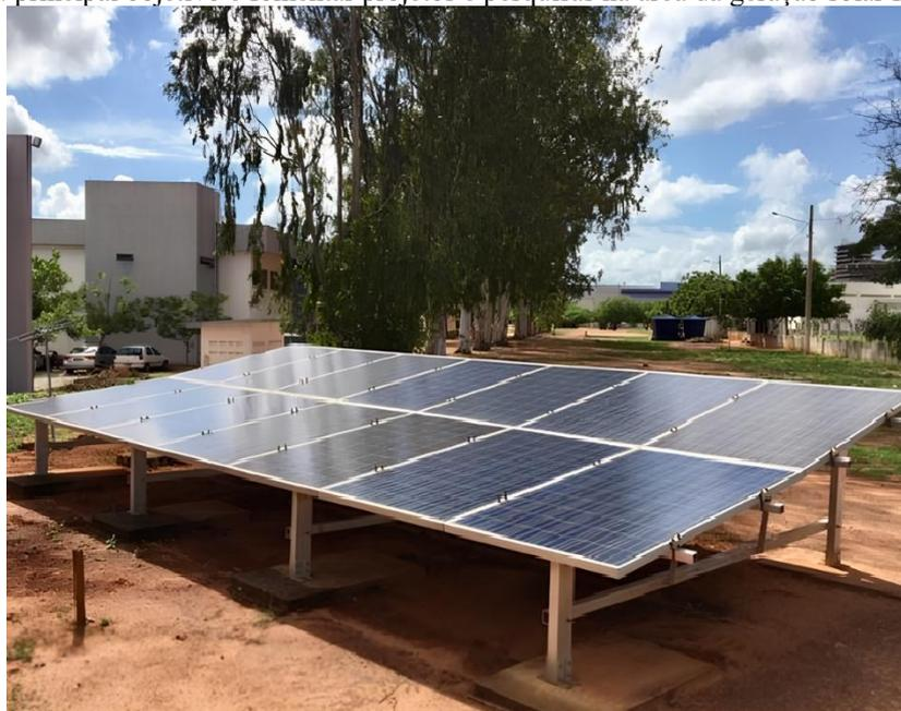
FIGURA 2. Mini usina solar fotovoltaica Mossoró I de 3,43 kWp (adaptada de [9]).
