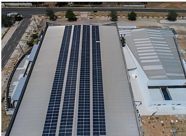
FIGURA 7. Vista superior das Usinas Solares Mossoró V e VI de  $185,65 \text{ kWp}$  (adaptada de [9]).
