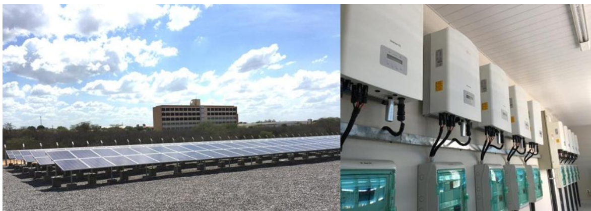
FIGURA 3. Usina Solar Mossoró II de 150,8 kWp e inversores trifásicos da empresa Ginlong Technologies Solis (adaptada de [9]).
