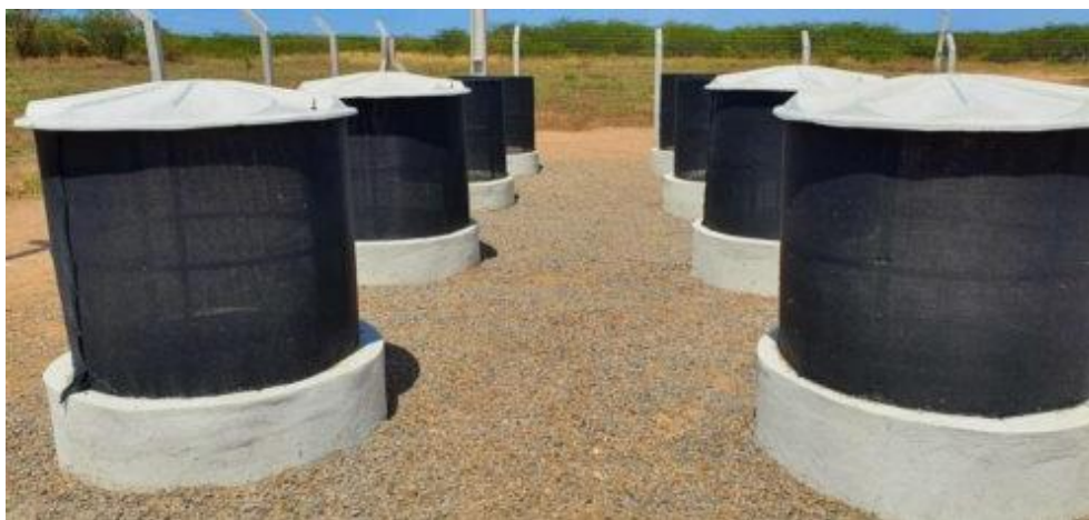
FIGURA 5. Usina de compostagem da UFERSA campus Mossoró (adaptada de [11]).
