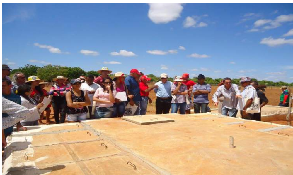
Figura 3 – Estação de tratamento de águas residuárias do P. A. Milagre/ RN.
