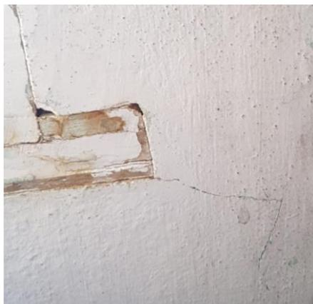
**Figura 2** - Fissura na extremidade inferior direita de uma das janelas da residência.
