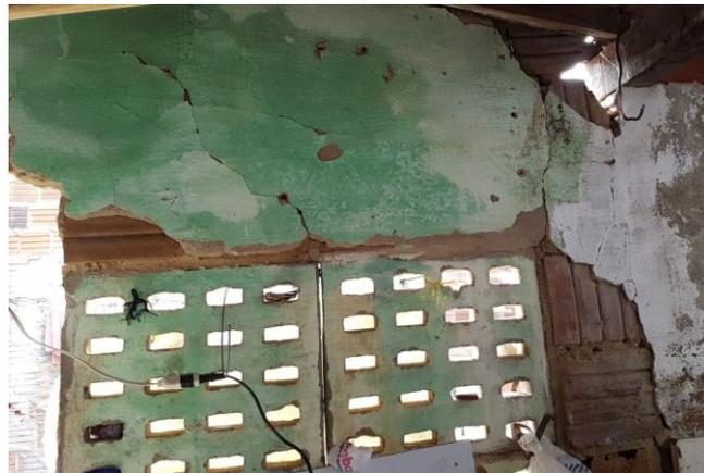
**Figura 4** - Trincas na área de serviço devido sobrecarga do telhado na alvenaria.
