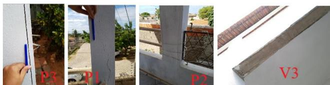
**Figura 3** - Fissuras na estrutura.
